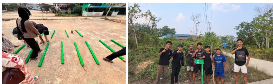
Gambar 13. Pembuatan dan Pemasangan Plang Nama Jalan/Pembatas RT Desa Muara Untu
