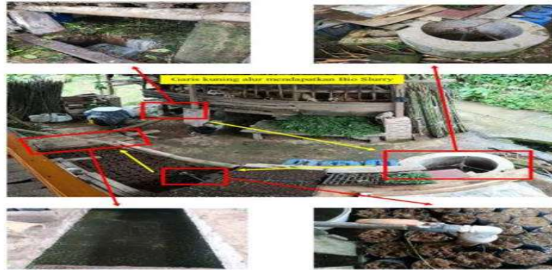
Gambar 3. Instalasi Digester untuk Pembuatan Produk BIOS+
