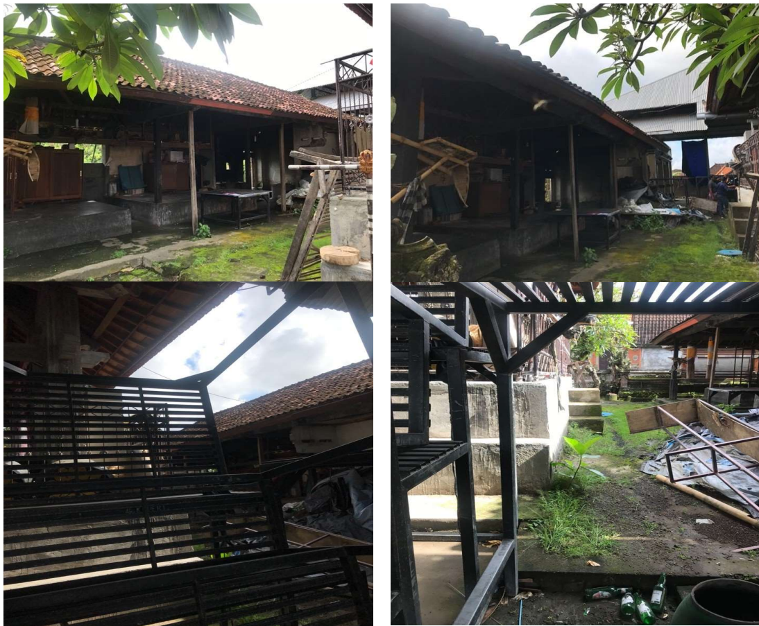
Gambar 1. Kondisi Eksisting Bangunan
