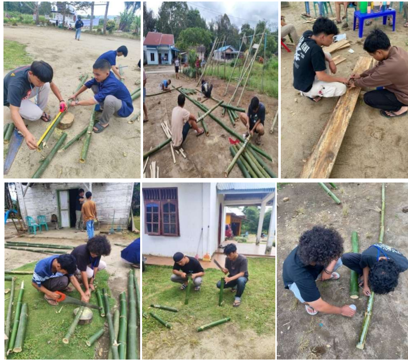
Gambar 1. Pembuatan Tiang Penunjuk Jalan
