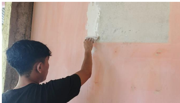
Gambar 1. Memperbaiki Retakan pada Dinding
