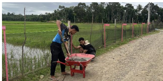
Gambar 3. Proses pengecoran plang
